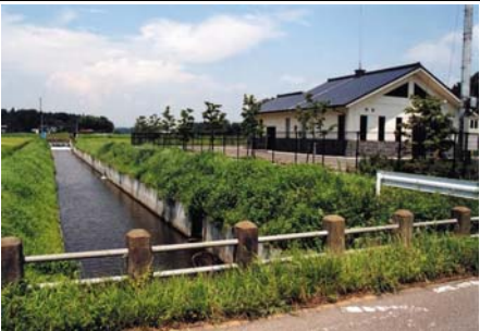
【農業集落排水施設】
