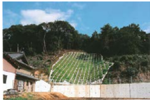
治山施設の設置による緊急的な復旧整備
