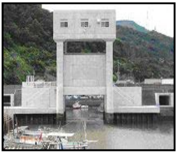
津波、高潮対策としての水門整備
