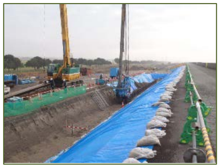
鋼矢板打設による耐震対策
