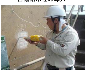
老朽化した施設の機能診断
