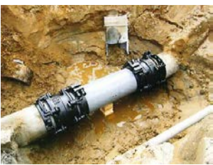
漏水防止のための整備
