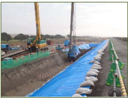
鋼矢板打設による耐震対策
