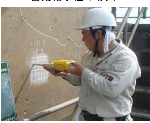
老朽化した施設の機能診断
