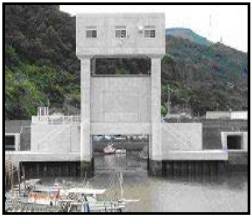
津波、高潮対策としての水門整備
