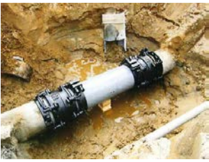
漏水防止のための整備
