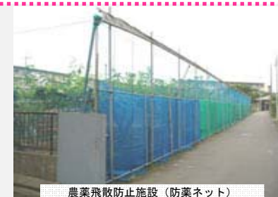
農業飛散防止施設（防薬ネット）
