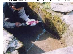
水路のひび割れ補修
