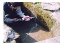
水路のひび割れ補修
