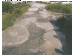
農道の窪みの補修
