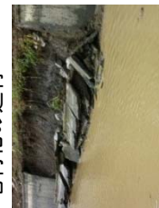
側壁が倒壊した水路
