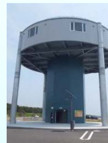
津波避難タワー
