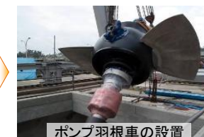
ポンプ羽根車の設置
