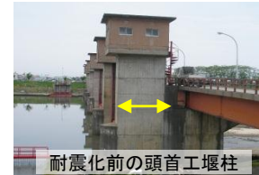
耐震化前の頭首工堰柱
