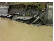
側壁が倒壊した水路
