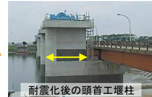
耐震化後の頭首工堰柱
