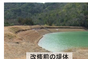
改修前の堤体
