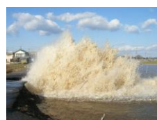
パイプラインの破裂
