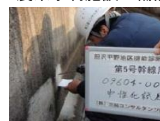
水路の機能診断
