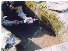
水路のひび割れ補修
