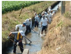
水路の泥上げ
