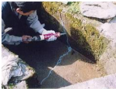
水路のひび割れ補修
