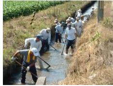
水路の泥上げ
