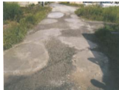
農道の窪みの補修
