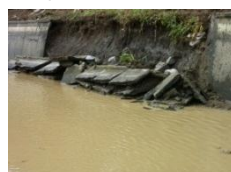
側壁が倒壊した水路
