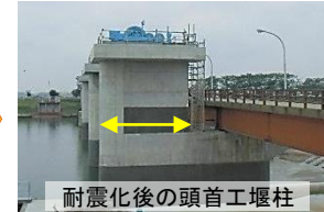
耐震化後の頭首工堰柱
