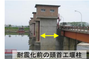
耐震化前の頭首工堰柱
