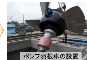
ポンプ羽根車の設置
