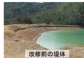
改修前の堤体
