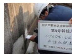
水路の機能診断
