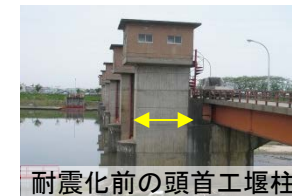
耐震化前の頭首工堰柱
