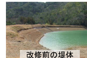
改修前の堤体
