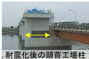
耐震化後の頭首工堰柱
