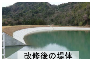
改修後の堤体
