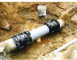
漏水防止のための整備
