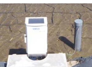
自動給水栓の導入
