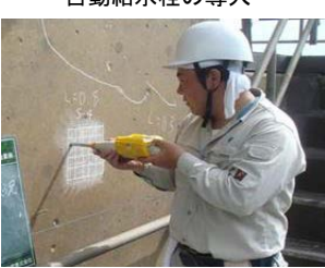
老朽化した施設の機能診断
