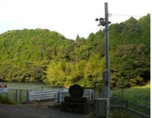
水位計や監視カメラの設置
