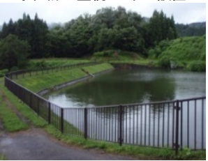
転落防止柵の整備
