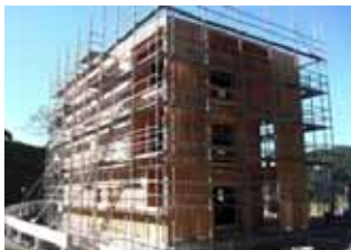
CLTの施工方法の確立及び コストダウンに向けたCLTを 活用した先駆的建築の支援
