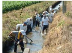
水路の泥上げ
