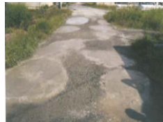
農道の窪みの補修
