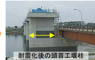
耐震化後の頭首工堰柱
