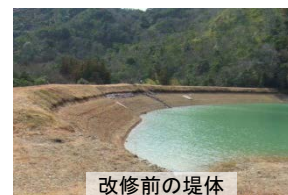
改修前の堤体
