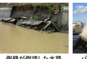
側壁が倒壊した水路
