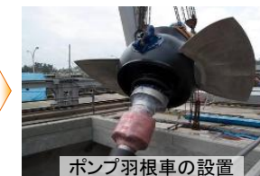
ポンプ羽根車の設置
