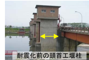
耐震化前の頭首工堰柱
