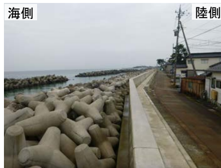
堤防嵩上げによる越波の防止
