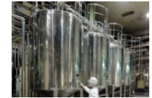
生クリーム貯蔵施設
