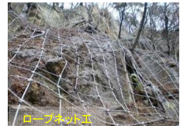
ロープネット工
