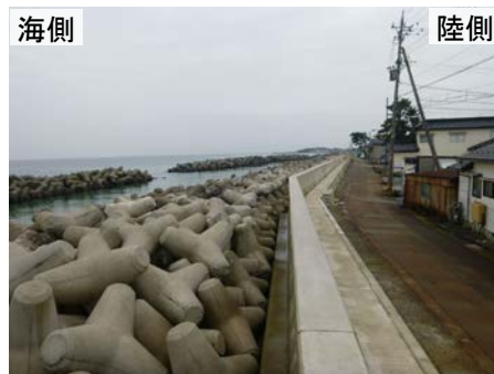
堤防嵩上げによる越波の防止
