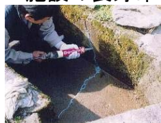
水路のひび割れ補修
