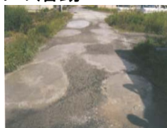
農道の窪みの補修
