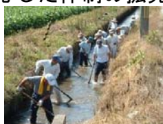
水路の泥上げ
