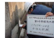
水路の機能診断
