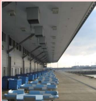
鳥獣対策を施した 陸揚岸壁
