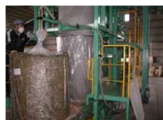
TMRセンター（プラント）
