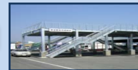
津波避難施設
