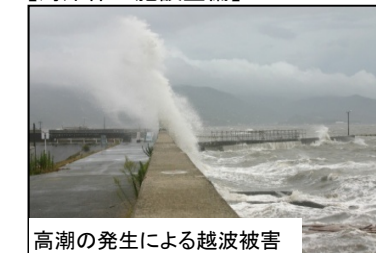
【海岸保全施設整備】
