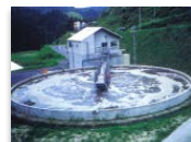
畜産環境対策施設
