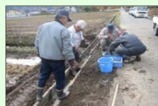
水路の補修 (施設の長寿命化)
