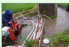
異常気象等後の 見回り・応急措置
