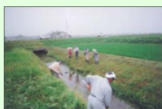
水路の泥上げ (日常の管理)
