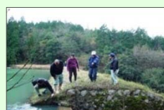
ため池の点検 (日常の管理)
