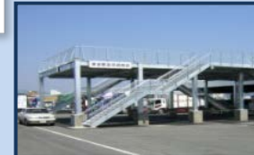
津波避難施設
