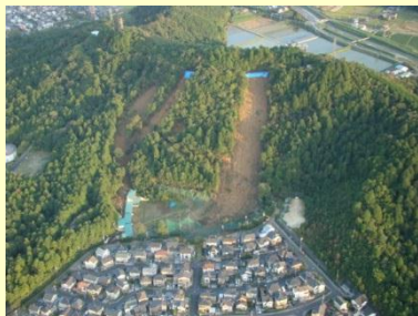
山腹崩壊の発生状況
