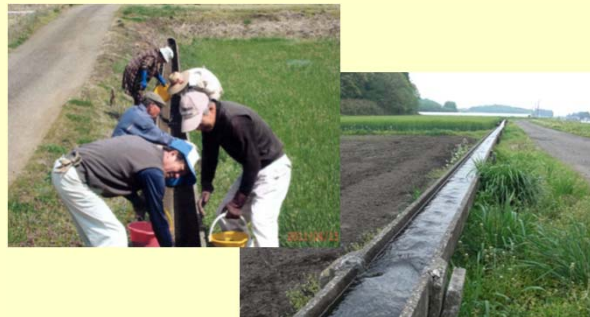
地域での復旧活動により通水
