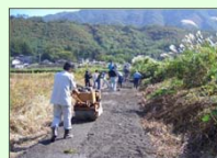
砂利舗装を アスファルト舗装へ
