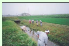
水路の泥上げ (日常の管理)
