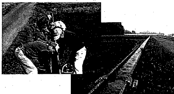
地域での復旧活動により通水
