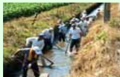
道水路の管理
