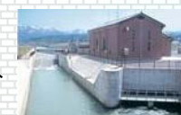
小水力発電施設
