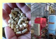
木質ペレット・ボイラー
