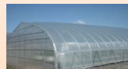
外張の多重化 (二重膜化したハウス)
