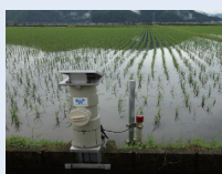
情報端末で水深を監視しながら給水/止水を遠隔操作。
