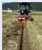
明渠施工の 直進精度も高い
