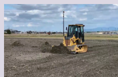
ICT均平化施工
