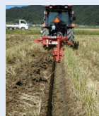
明渠施工の 直進精度も高い
