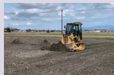
ICT均平化施工
