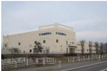
米粉製粉工場
