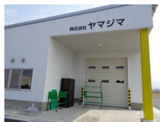
令和5年3月竣工された ねぎ集出荷場
