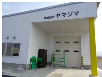
令和5年3月竣工された ねぎ集出荷場
