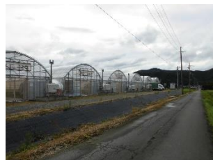
大型鉄骨ハウス
