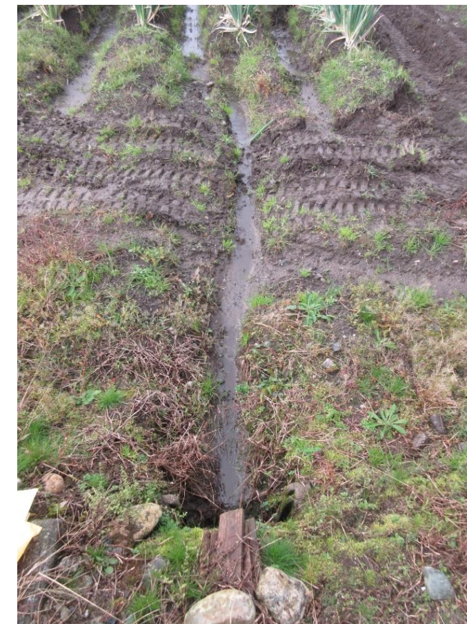
ほ場の排水口
