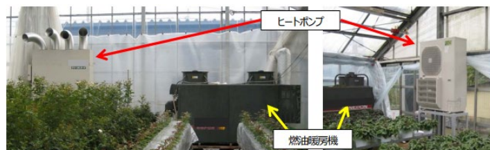
ヒートポンプと燃油暖房機のハイブリッド運転による 燃油使用量の削減
