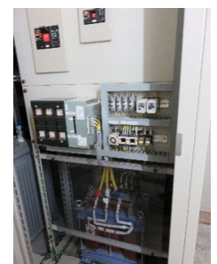
【低圧コンデンサ盤内部】
