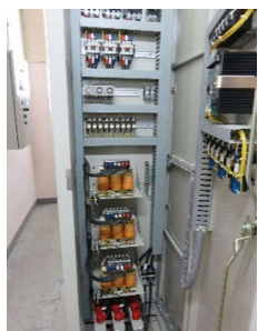
【低圧コンデンサ盤内部】
