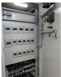
【低圧動力盤内部】
