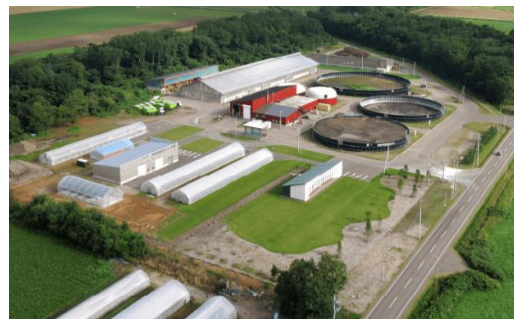
【バイオガスプラント全景】
