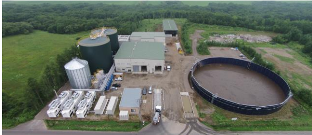
別海バイオガス発電株式会社
