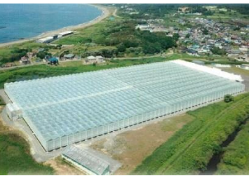
【ハウス施設の全景】
