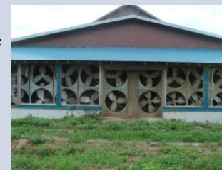
Exhaust fan on barn wall
